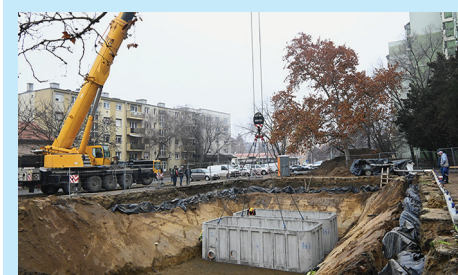
A Kossuth utcán föld alá süllyesztett záportárolókkal próbáljuk segíteni az esetleges villámárvizek levonulását
